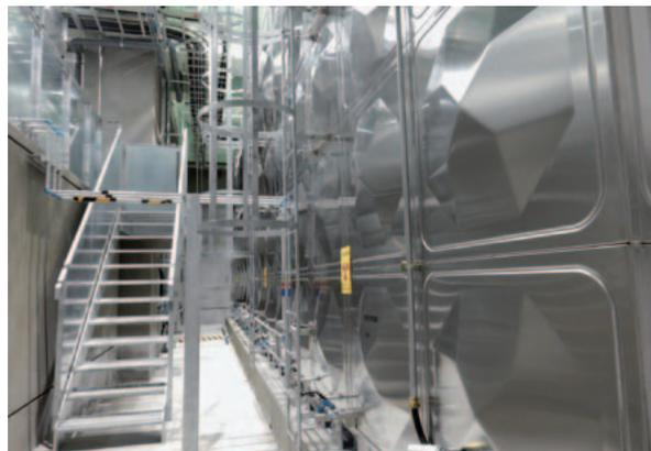
写真3 80m<sup>3</sup>の貯留槽および希釈槽
