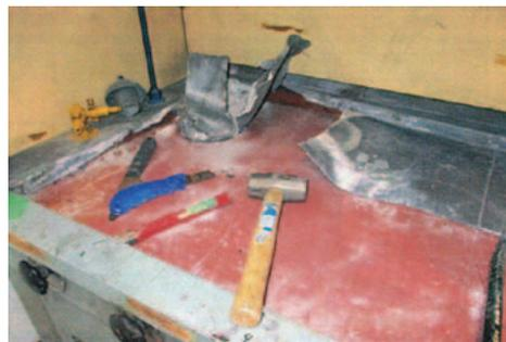
写真3 フード作業面の鉛の剥ぎ取り作業
