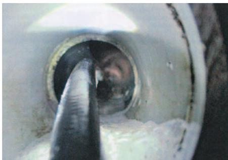
写真1 排水管の高圧洗浄作業
